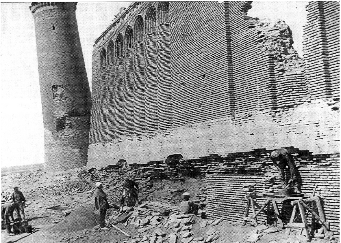
Рис. 4. Укрепление фундаментов западного крыла фасада Рабати-Малик, 1928 г.
